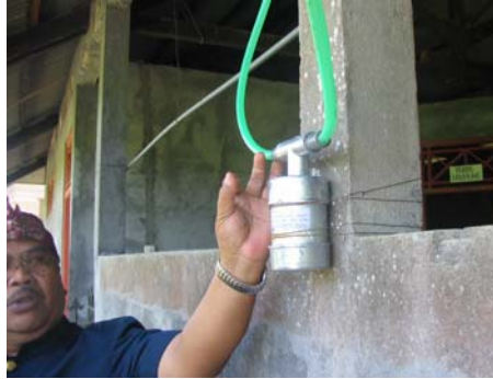
Gambar 3 : Klep Pengaman Gas Sebelum Masuk ke Tabung Penampung Gas
